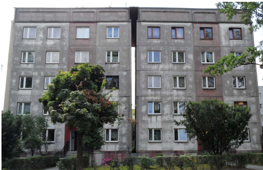
Rys. 1. Widok ogólny budynku (fot. P. Strzałkowski)
